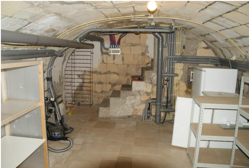
29: De oorspronkelijke 18 e eeuwse kelder in mergel met korfbooggewelf.
