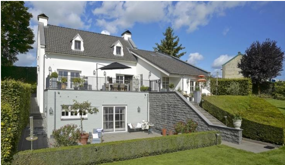
41: De achtergevel in de huidige situatie (bron: INeX architecten)
