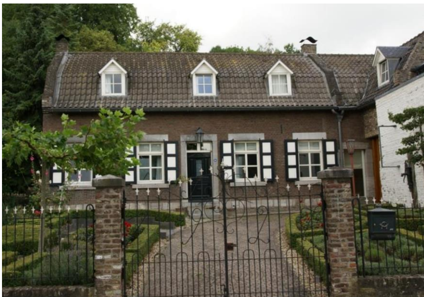
36: Lage Kanaaldijk 104 in Sint-Pieter is een woonhuis uit het midden van de 19 e eeuw. Het pand is aangewezen als kenmerkend pand. Het bouwwerk is o.a. kenmerkend gewaardeerd omdat aan de uiterlijke kenmerken van het object te zien is dat het bouwwerk een oude(re) kern heeft en daarmee bouwhistorisch van waarde bezit en de straatgevel een waardevolle maatvoering en ritmering bezitten. (bron: cultuurhistorische waardenkaart Maastricht)
