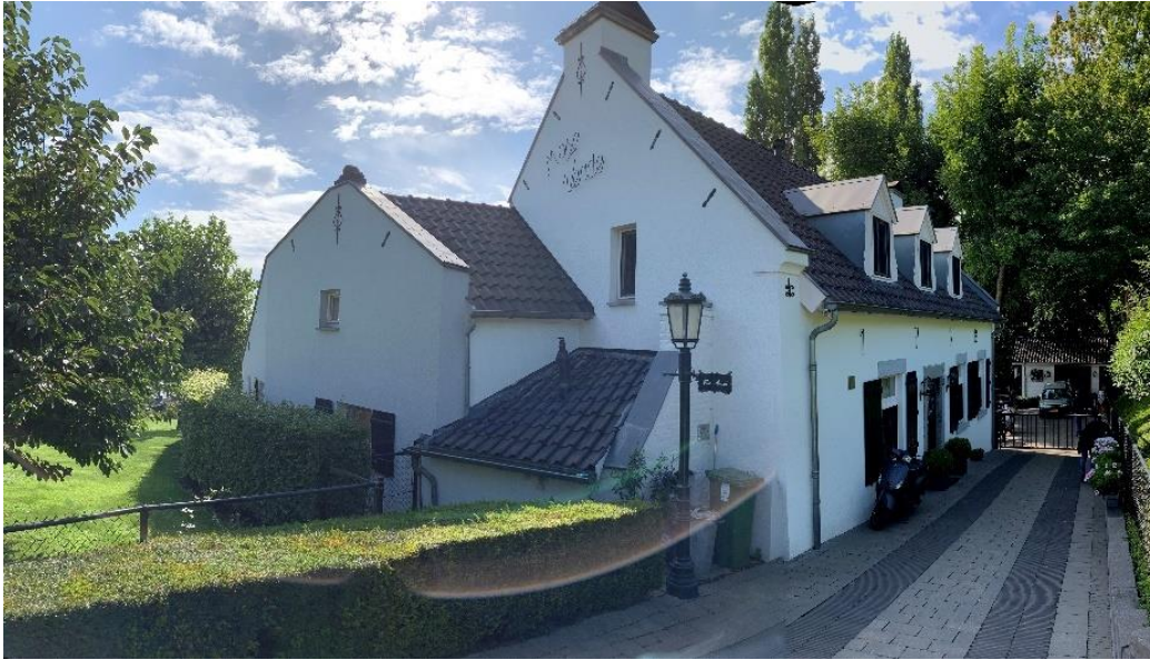
39: De linkerzijgevel en de voorgevel in de huidige situatie (uit drie foto's samengestelde foto).
