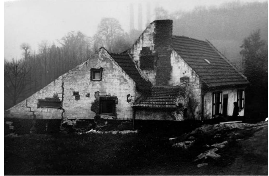
40: De linkerzijgevel en de voorgevel tijdens de verbouwing in 1968 (bron: fam. Consten)
