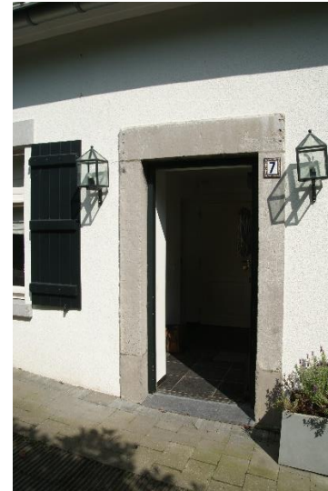
24: De nog oorspronkelijk 18 e eeuwse omlijsting in Naamse steen van de voordeur. De omlijsting is tijdens de verbouwing in 2006 iets naar voren (gelijk met het stucwerk op de gevelisolatie) en hoger in de gevel geplaatst.
