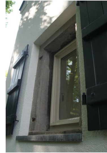
25: De nog oorspronkelijk 18 e eeuwse omlijsting in Naamse steen van het venster in de rechter zijgevel. De opdikking van de gevel door de gevelisolatie en het stucwerk is hier waarneembaar.
