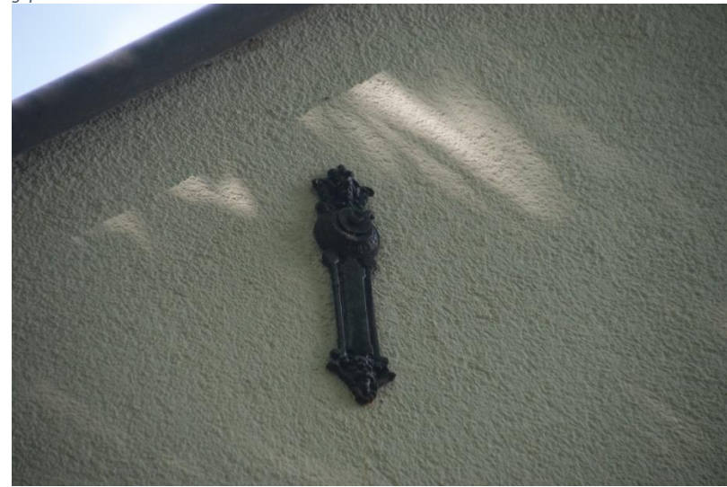
28: Een van de historiserende muurankers. Mogelijk is daarvoor het schild van een deurklink gebruikt.
